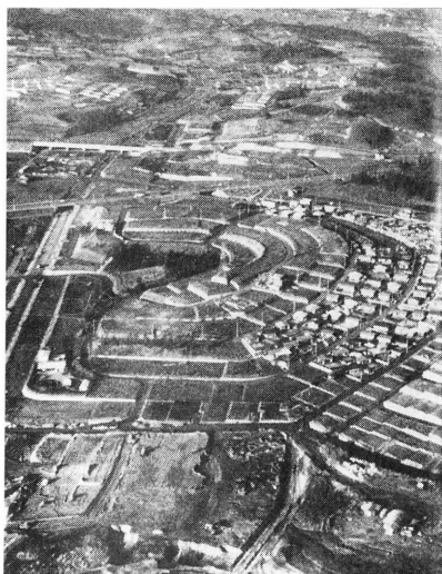
区画整理を終えた恩田第一地区
