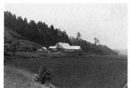
恩田第一地区の起工式会場
