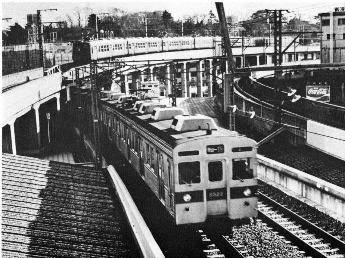
二子玉川園で 大井町線と 立体交差する 新玉川線
