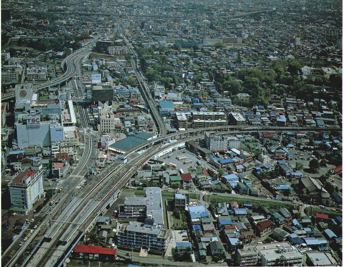
二子玉川園駅附近全景 新玉川線・田園都市線、大井町線、国道246号線、
