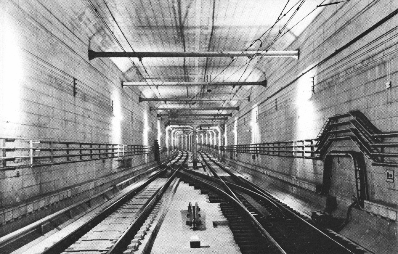
完成した箱型ずい道 用賀附近
