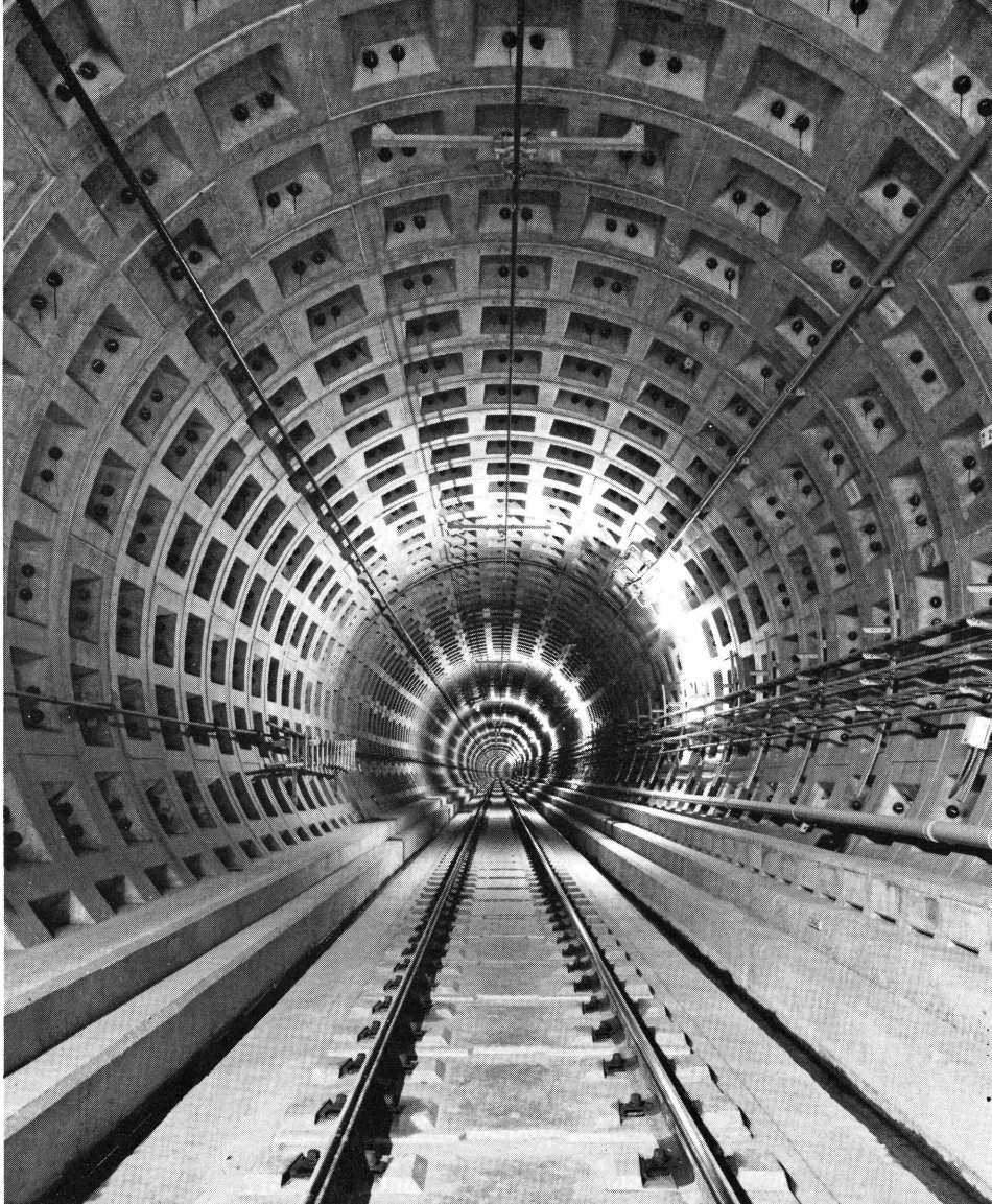
シールド 完成した円型ずい道 駒沢附近
