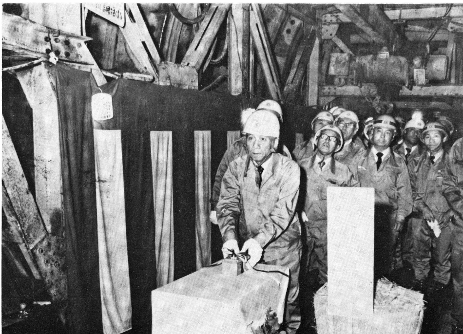
シールド貫通式 スイッチを押す田中副社長 昭和50年 4月9日 (道玄坂下附近)
