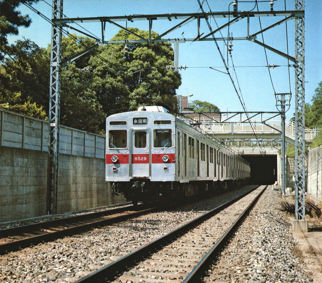
瀬田坑口を入る8500形車両
