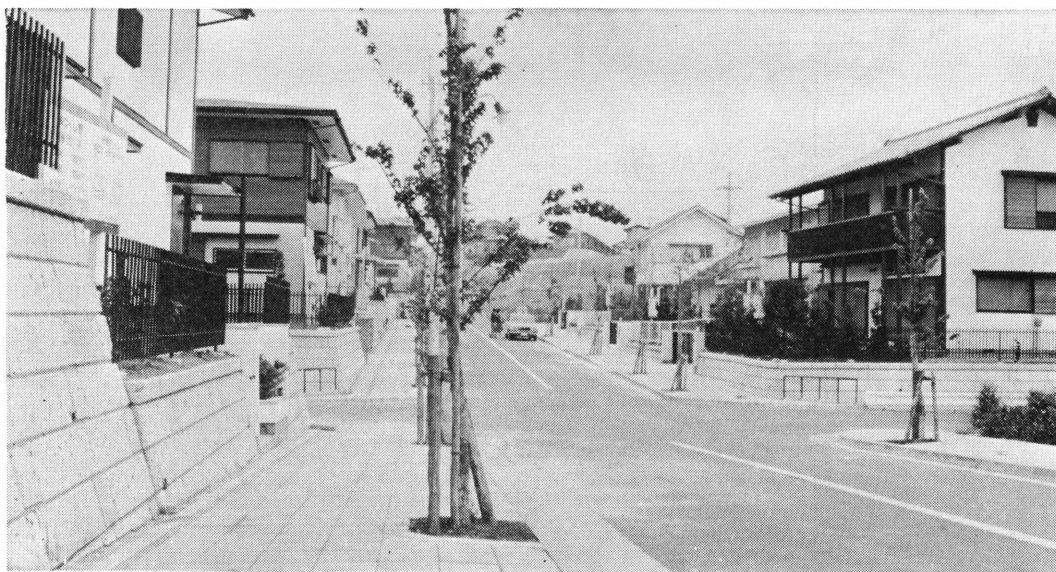
東急不動産によるつくし野の街づくり
