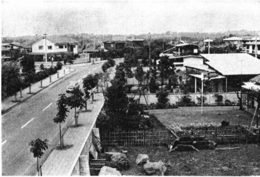
住宅の建築が進んだ野川地区
