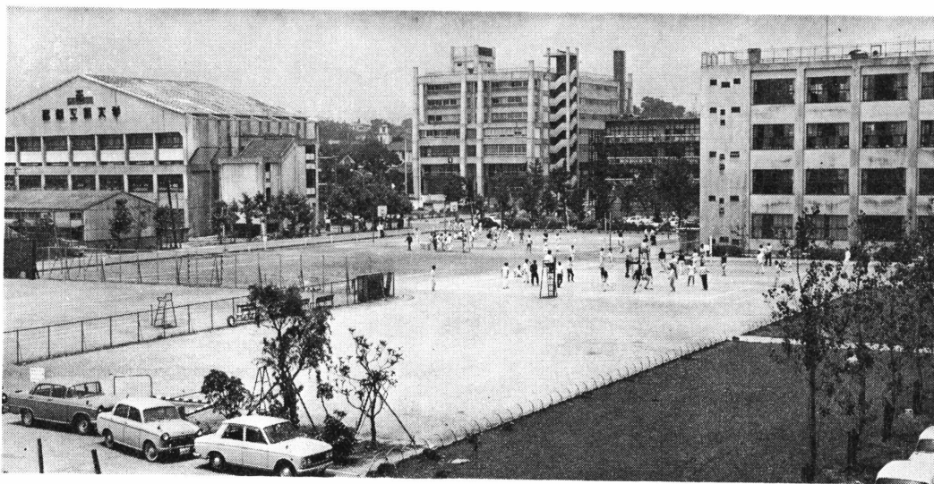
多摩川のほとりに建つ武蔵工業大学
