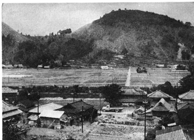
河津駅予定地付近
