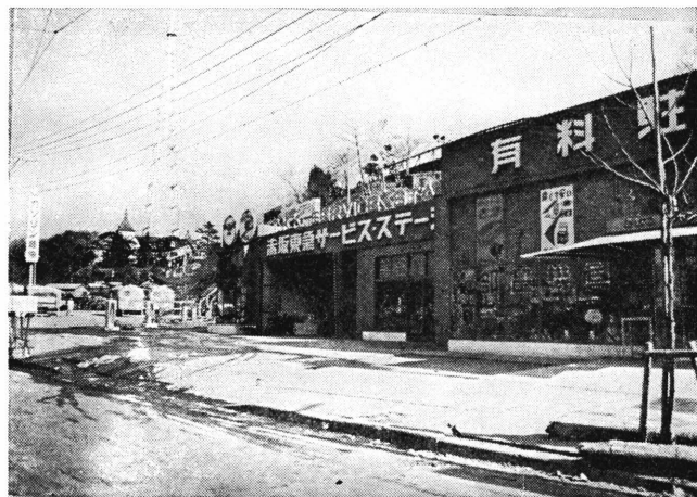
赤坂見附に設けられた東急赤坂サービス・ステーション
