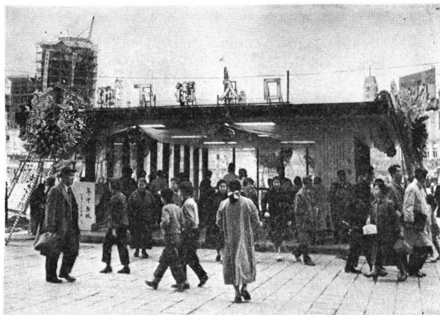
昭和32年11月、竣工当日の渋谷地下街入口
