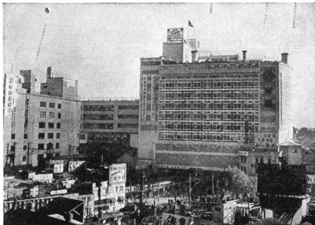
竣工後、東横西館として開業した東急会館
