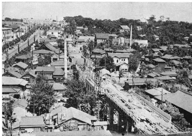
建設中の東京高速鉄道（左は宮益坂）
