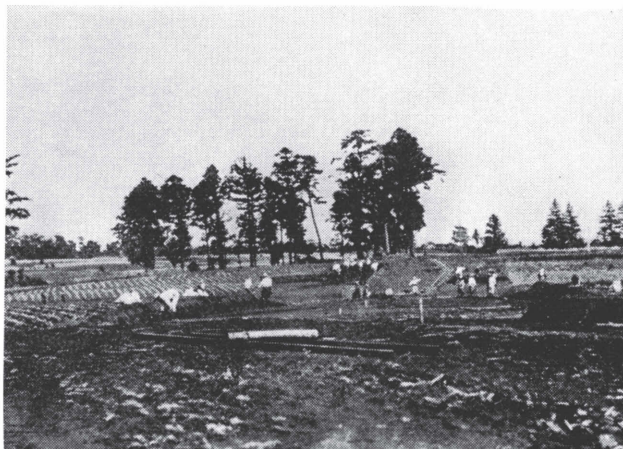
整地中の洗足分譲地（大正11年）
