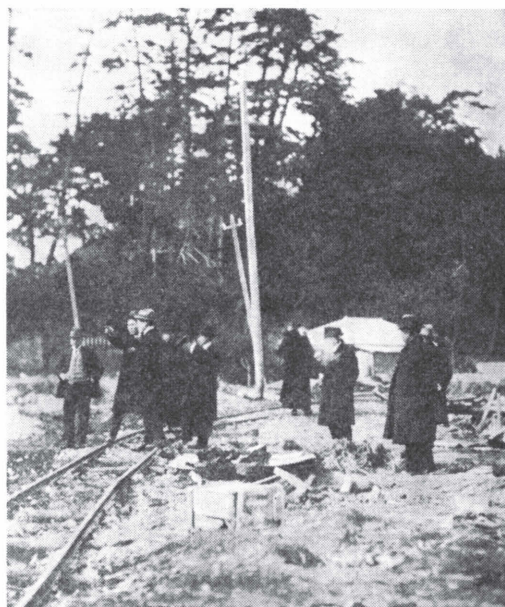
工事状況を検分する役員（多摩川～丸子間）
