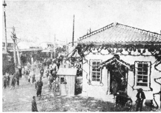
開業当時の阪神電気鉄道神戸（三宮）停留所
