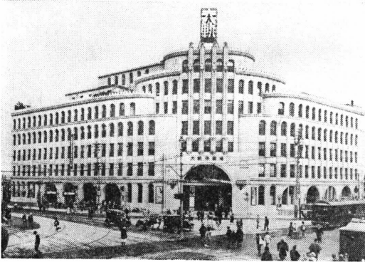
大阪電気軌道の大軌ビルヂング
