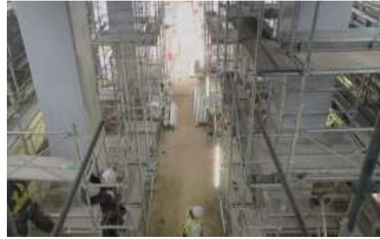
高架下耐震補強工事
