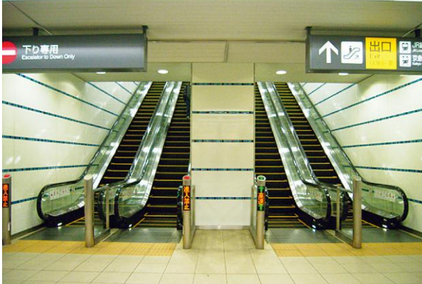
エスカレーターの増設(横浜駅)
