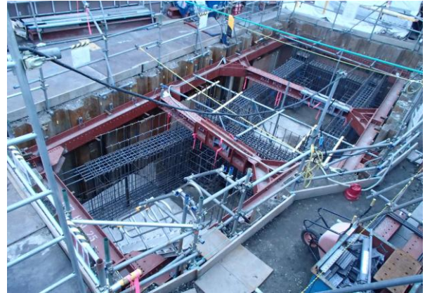
駅の改良工事(菊名駅)
