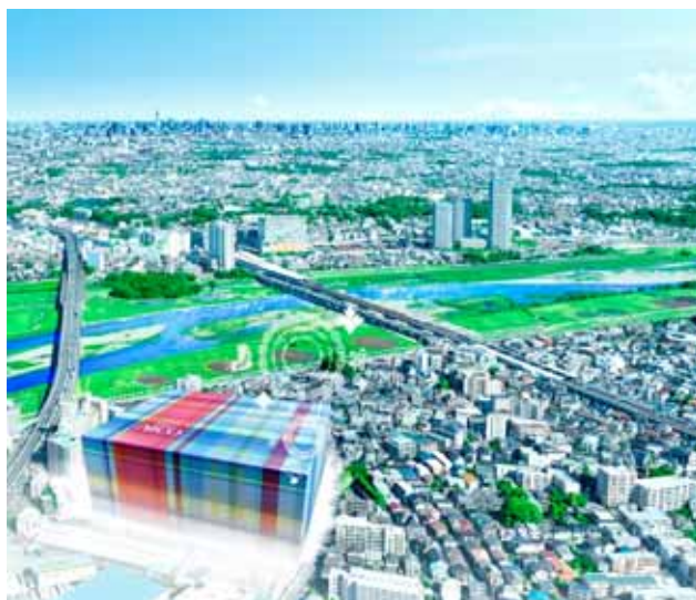
現地上空より二子玉川ライズ方面を望む
