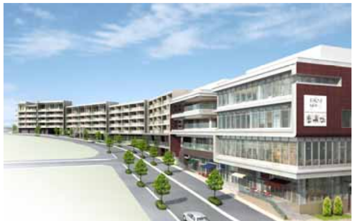
全体外観 イメージパース 手前：たまプラーザ テラス リンクプラザ (本施設) 奥：ドレッセ たまプラーザ テラス
