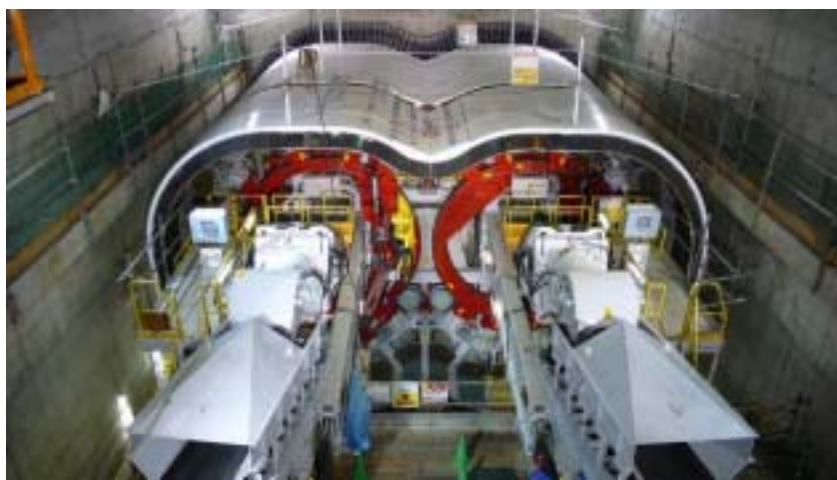
渋谷～代官山間で掘削を行うシールドマシン
