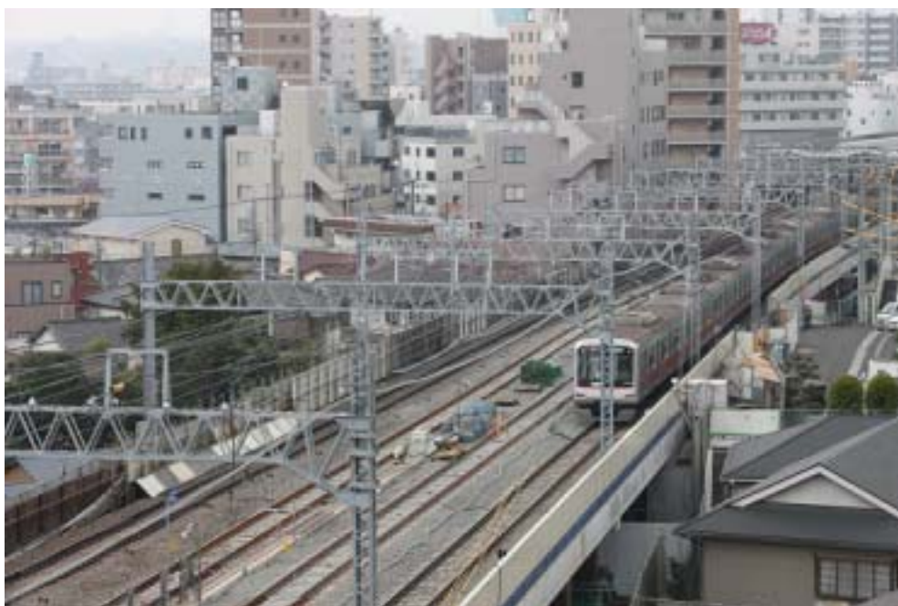
線路拡幅工事が進む溝の口駅付近
