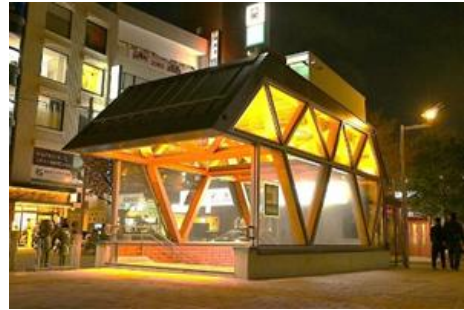
▲「Green UNDER GROUND」桜新町駅 西口出入口上家
