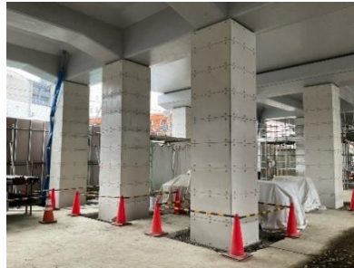
▲東横線・目黒線 多摩川駅～新丸子駅間 補強後の高架橋柱
