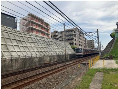
▲東横線綱島駅～大倉山駅間 補強後の法面
