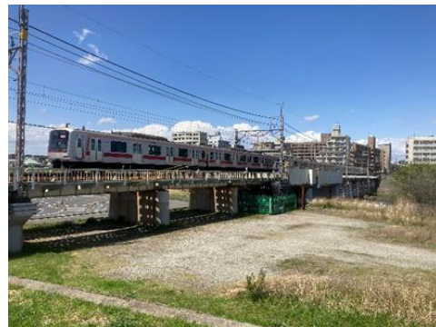
▲東横線鶴見川橋梁
