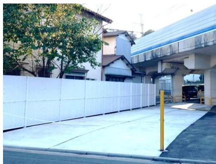
写真2 施工完了後の状況
