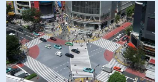
路面の温度上昇を抑制する舗装
