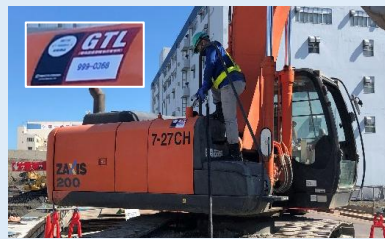
建設現場における低炭素燃料 (GTLやバイオ燃料)の導入
