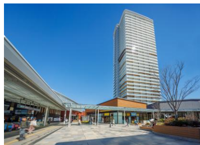
【ドレッセタワー南町田グランベリーパーク】 2024年1月に竣工した駅直結集合住宅。再エネ電気100%導入の 他、太陽光追尾採光システム採用やEV急速充電機、カーシェア リングを備える等カーボンニュートラルな暮らしを提案。
