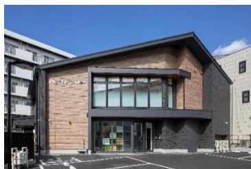
▲東急軌道工業(株)梶が谷事業所外観
