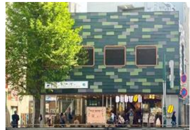
▲田園都市線 駒沢大学駅東口ビル
