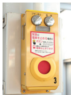
非常停止ボタン
