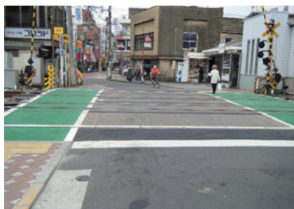
拡幅した下丸子駅付近の踏切
