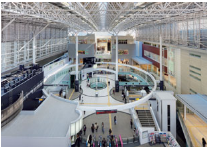
コンコース屋根のトップライトとコンコース床の吹抜け
