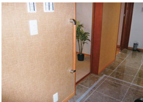
玄関に手すりを設置しています
