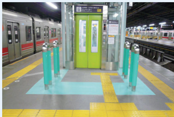
転落防止柵(自由が丘駅)
