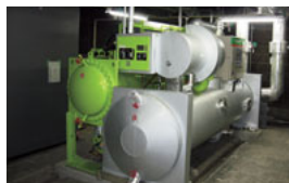
「札幌東急プラザ」の例 熱源機器の更新。高効率ターボ冷凍機の採用。インバータ制御による省エネ運転化。CO 2 135t/年削減。
