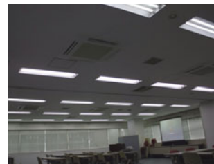
本社会議室のLED照明
