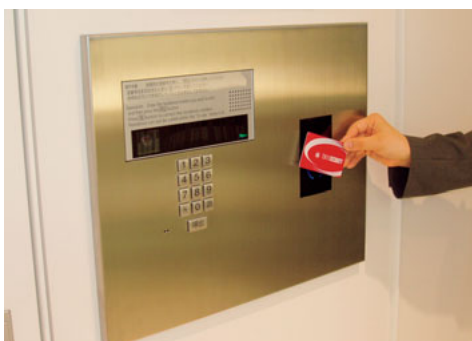
ICカードシステム+電気錠
