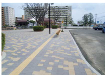
つきみ野駅駅前広場(改修後)
