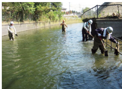
用水路清掃作業
