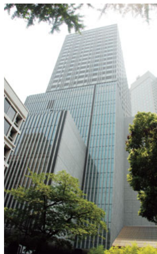
東急キャピトルタワー
