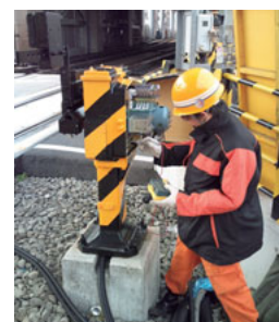
電気設備の保守
