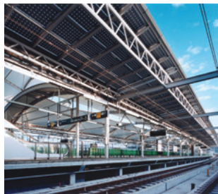
コンコースの屋根部分
