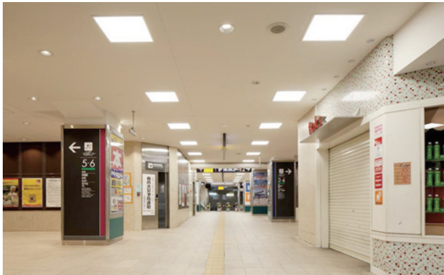
自由が丘駅コンコースのLED照明
