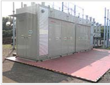
設置された蓄電設備
