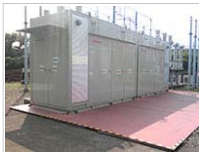
設置された蓄電設備
