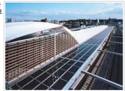
元住吉駅太陽光発電設備
