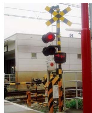
警報機 見通しの悪い踏切では、警報灯の数を増やす、どの方向からでも視認できるタイプの警報灯を設置するなど、視認性を高める工夫をしています。
