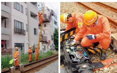
電気係員が電車線の状態を確認
