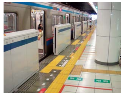
ホームドアと誘導ブロック 線路への転落防止と列車への接触防止のため、目黒線の各駅にホームドアを設置しています。また、各駅には目の不自由なお客さまのための誘導ブロックを設置しています。
