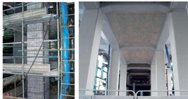
高架橋耐震工事 工事中(左)、完成(右)
