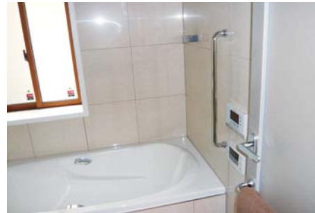
浴室に手すりを設置しています
