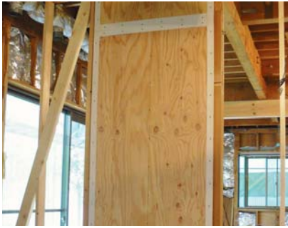
梁柱接合部SRF補強 補強材を接着剤で貼り付けて接合部を補強します。既存の木材を傷つけずに補強ができます。
