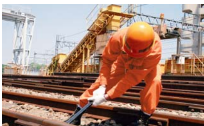
線路の状態を、日々、点検しています
