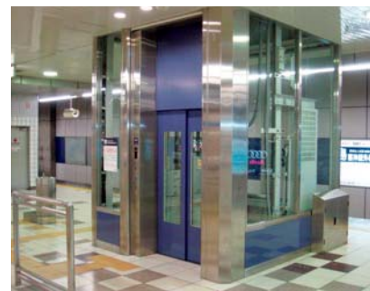
エレベーターと 転落防止柵 防犯対策として、内部が確認できるシースルー型や窓付きエレベーターの設置を進めています。また、線路への転落を防ぐために、エレベーターの前に転落防止柵を設置しています。
