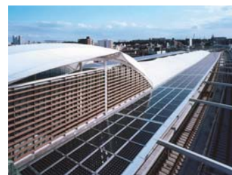
元住吉駅太陽光発電設備
