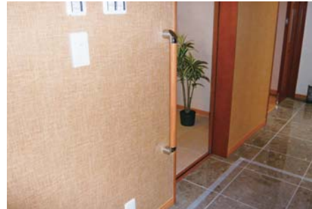
玄関に手すりを設置しています
