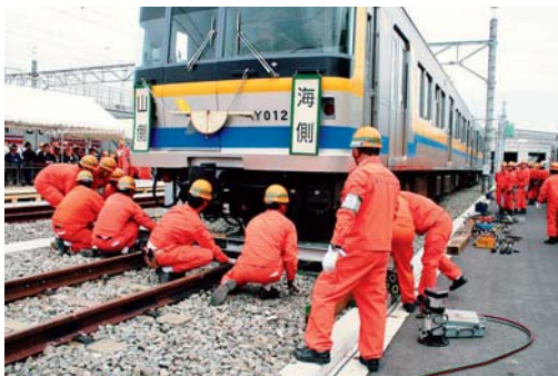
ジャッキを使って脱線した列車を持ち上げる
