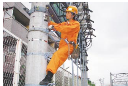
電気係員が電車線の状態を確認
