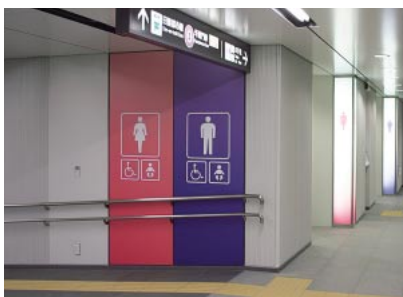
身長差に配慮した2段手すりを採用
