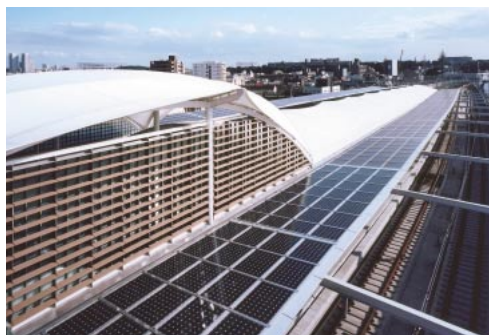
元住吉駅の太陽光発電設備
