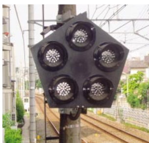
特殊信号発光機 非常ボタンが押されたり障害物検知装置が異常を検知したときに、赤く点滅して列車の運転士に異常を知らせます。ATCと連動しているため、東横線、目黒線、大井町線、こどもの国線では、接近する列車を自動的に減速させます（田園都市線に踏切はありません）。
