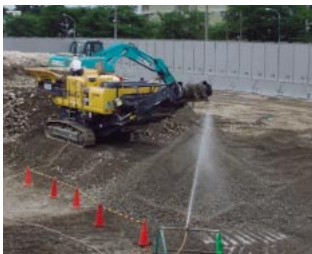
ガラパゴスでコンクリートがらを散水しながら破碎
