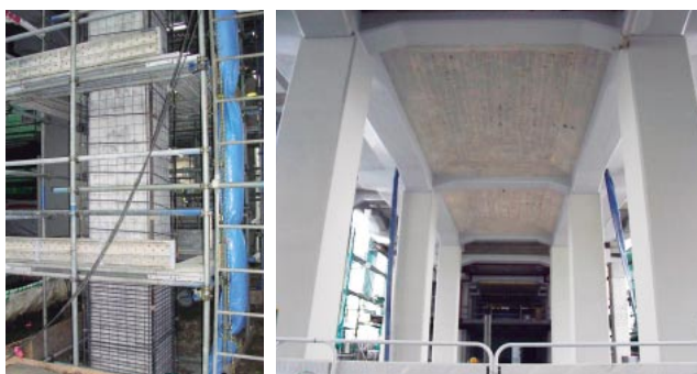
高架橋耐震工事 工事中(左)／完成(右)
