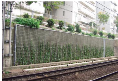
用賀～二子玉川間の下り線の擁壁
