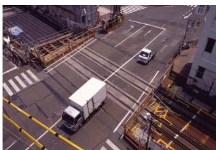
武蔵小山2号踏切立体交差化後
