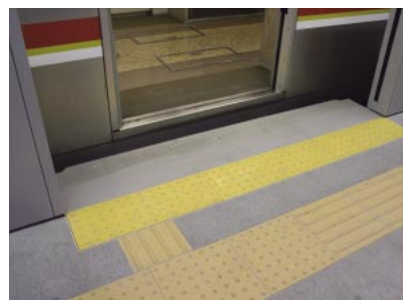
車両との隙間を解消する可動ステップ
