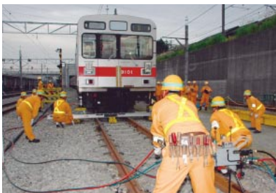
ジャッキを使って脱線した車両を持ち上げる
