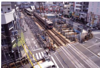
武蔵小山2号踏切立体交差化前
