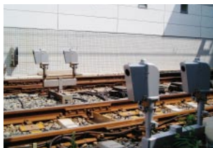
障害物検知装置 踏切内で立ち往生している自動車などの障害物を、赤外線などによって検知します。
