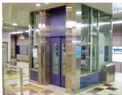
エレベーターと転落防止柵
