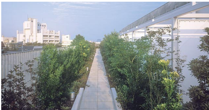
緑化した北側の屋上。現在は養生中
