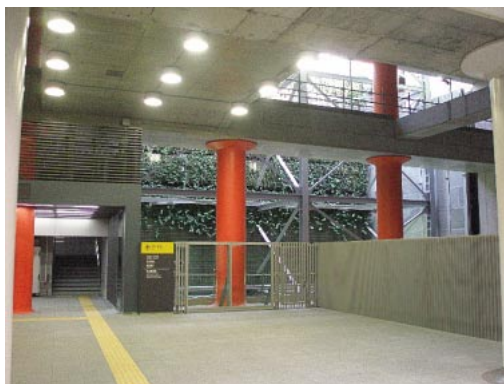
文化街区側自然換気開口
