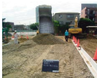
骨材を仮設道路に搬入
