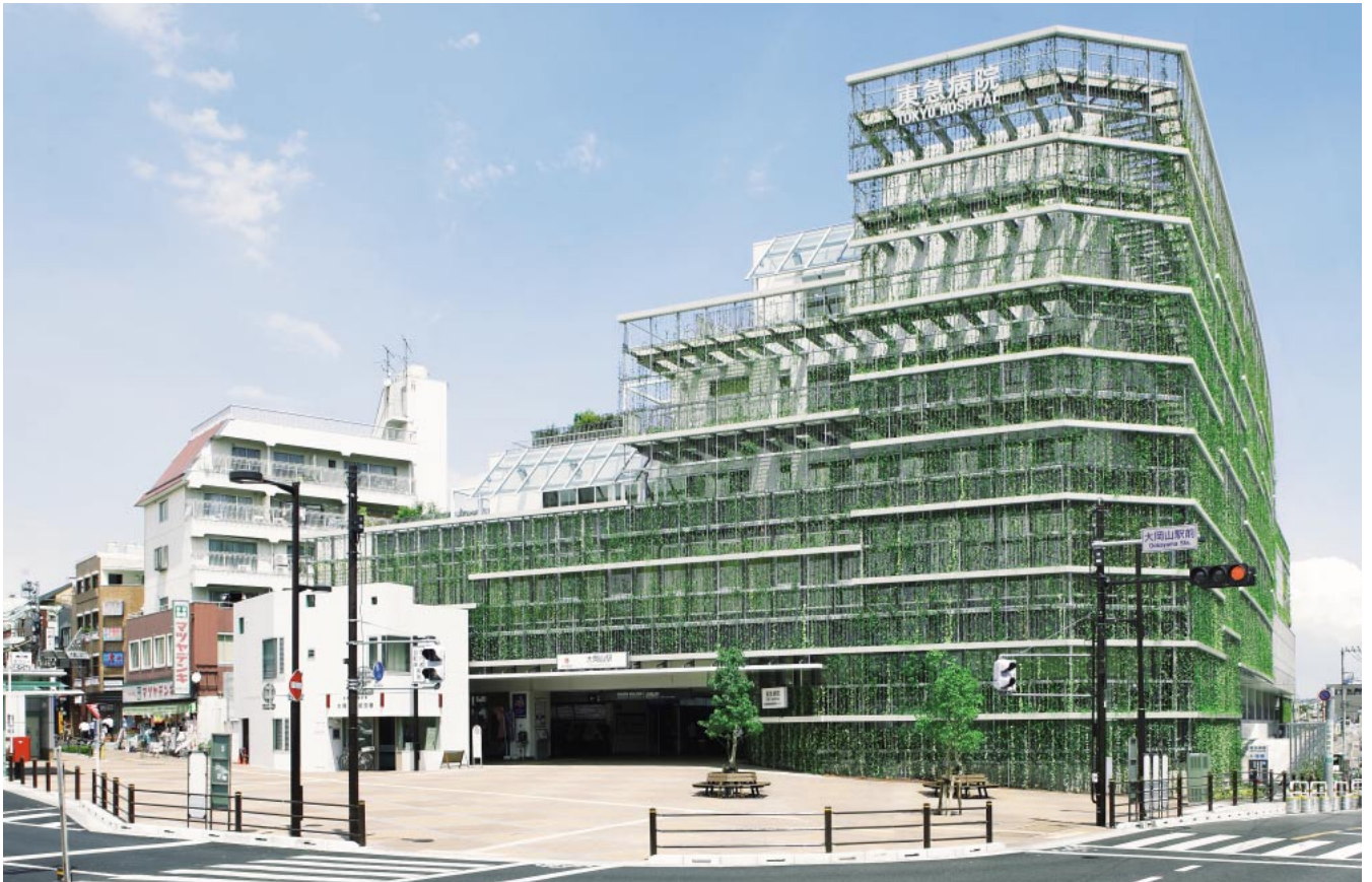
東急病院全景。この夏、壁面緑化のツタ植物が大きく育ち、文字通り「大岡山のやすらぎの丘」となった
