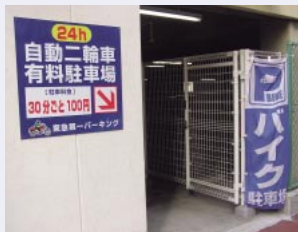
バイク駐車場の設置
