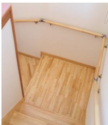
階段は勾配を緩やかに、回り部分もスムーズな動きで昇降でき、転落の危険を考慮して踊り場を設けています
