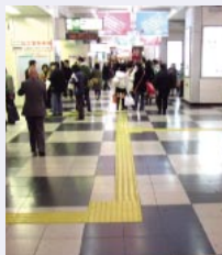
点字ブロックの設置
