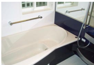
浴室は洗面所との段差を20mm以下にし、浴槽は手すりステップのあるものを採用しています
