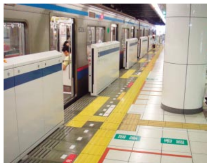
ホームドアと誘導ブロック
