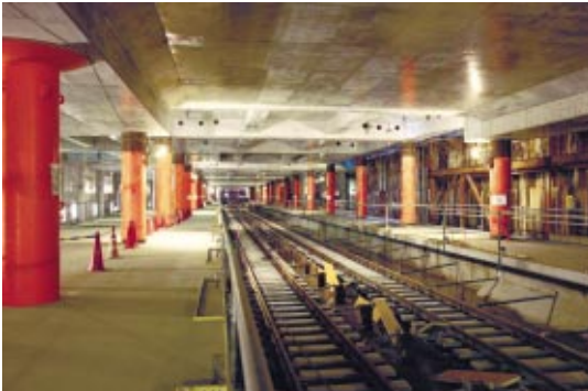
武蔵小山駅の地下化工事の様子
