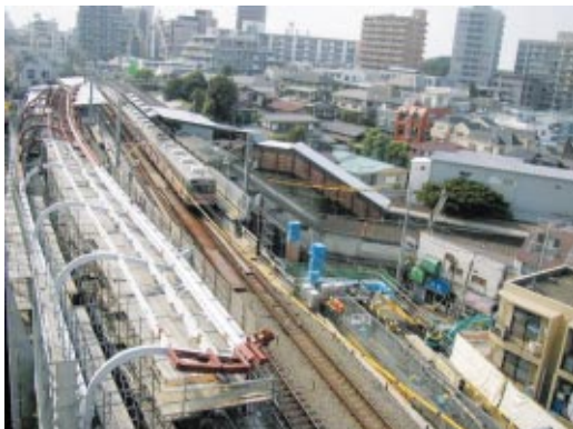
旗の台駅の改良工事の様子
