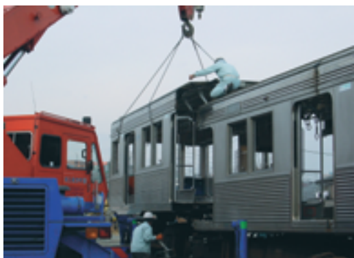
解体車両8000系から取り出したリサイクル率 87.8% (2003年度)
