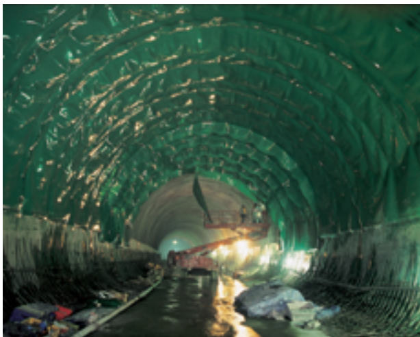
トンネル背面への防水シートのラッピング作業風景
