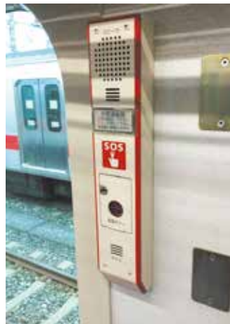
車内非常通報ボタン
