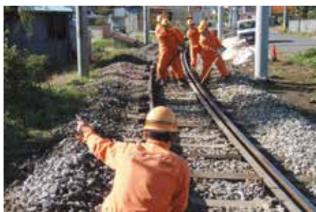
ベテラン社員と若手社員が合同で軌道整正の技術伝承を目的として、定期的に行っています
