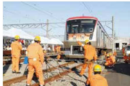
脱線した車両は油圧ジャッキを使用して、線路上に復旧させます
