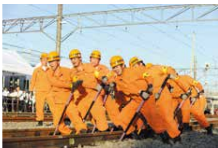
歪んだ線路(軌道)を複数の保線係員が力を合わせて整正します
