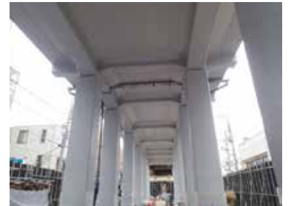
耐震補強工事後の高架橋
