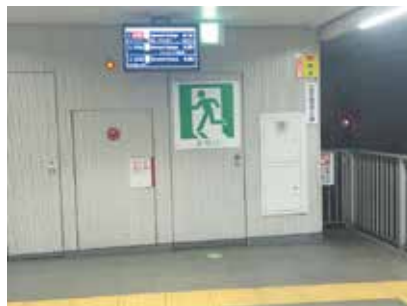
避難通路(非常口のご案内)の表示を大きく分かりやすくしました
