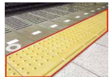
内方線付き点状ブロック
