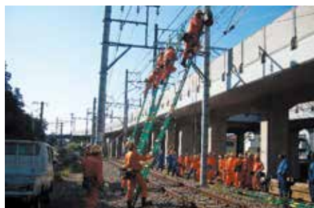
訓練施設には電柱や電車線、転つ機などが整備されています。電車線の断線や軌道落下事故を想定し、本番さながらの早期復旧に向けた訓練を定期的に行っています
