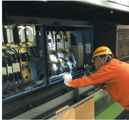
制御装置の点検
