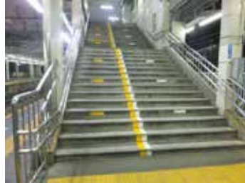
梶が谷駅階段の通行区分表示
