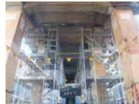
耐震補強工事中の高架橋
