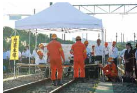
現地対策本部には、各部門の現場指揮者から復旧作業の進捗状況が報告されます
