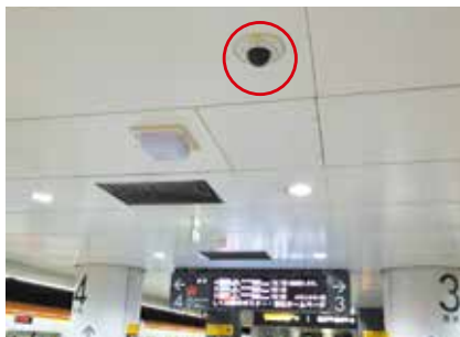
駅構内の防犯カメラ
