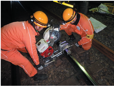
レール交換（レール切断）
