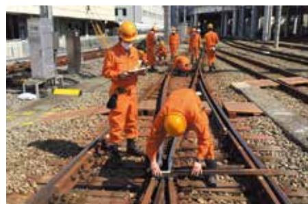
屋根車庫内において、ベテラン社員から若手社員への技術伝承として分岐器の検査、整備、調整を実施しています
