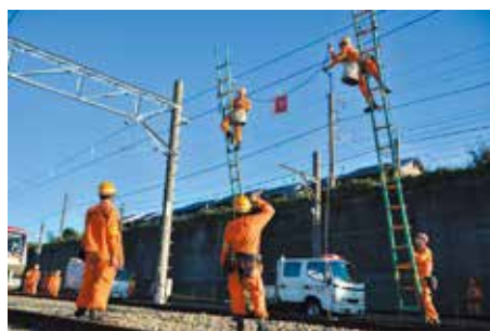
損傷した架線は、電気部の係員が速やかに復旧を行います
