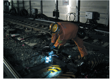
信号設備検査（転てつ器検査）
