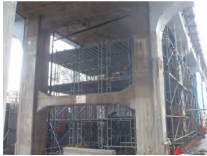
耐震補強工事中の高架橋
