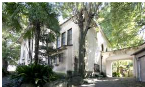
外観(改修工事前)
