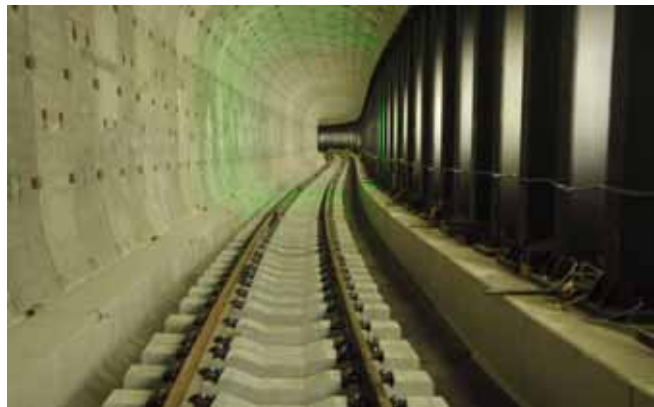
渋谷～代官山間のシールドトンネル
