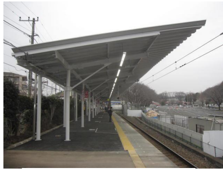
こどもの国駅ホーム屋根現地写真
