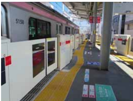
ホームドア設置
