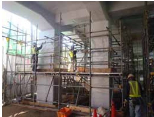
高架橋の耐震補強工事
