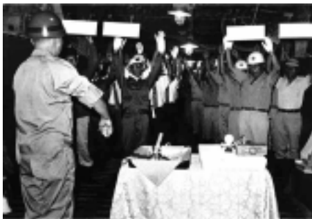
祝新玉川線・駒沢ずい道貫通 (昭和50年8月8日撮影)
