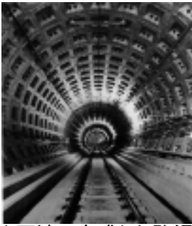
シールド工法で完成した駒沢付近の円形ずい道
