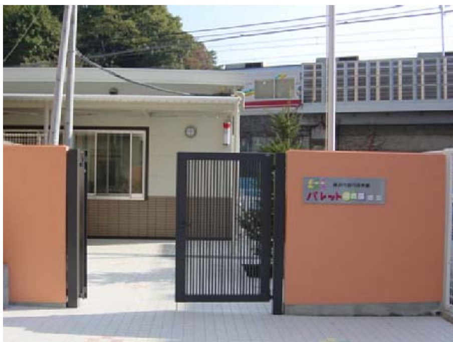
「パレット保育園・綱島」外観
