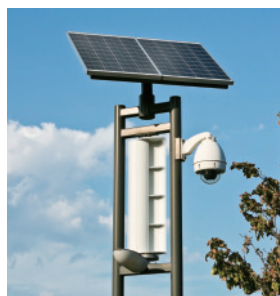
太陽光パネル
