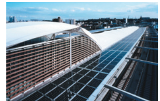
元住吉駅の太陽光発電システム
