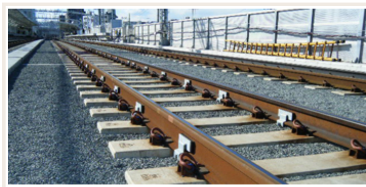
レールを挟むレールダンパー
