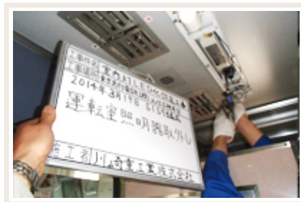
LED照明導入工事
