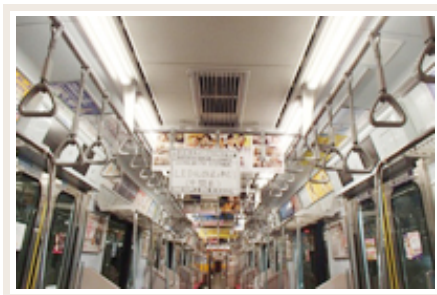
取付後のLED車内照明
