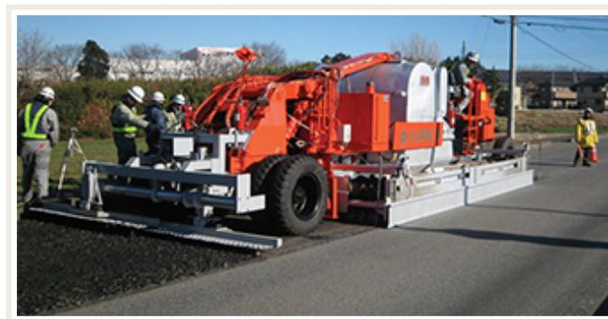
熱風循環式ヒータ車による既設舗装の加熱、掻きほぐし状況
