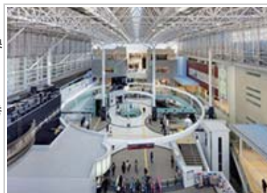
コンコース屋根のトップライトと コンコース床の吹き抜け
