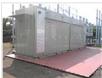
設置された蓄電設備
