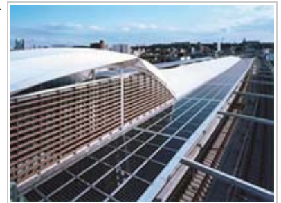
元住吉駅太陽光発電設備
