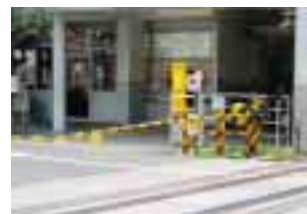
遮断かん グラスファイバー製を使用し、踏切内に取り残された自動車などが脱出しやすい構造になっています。
