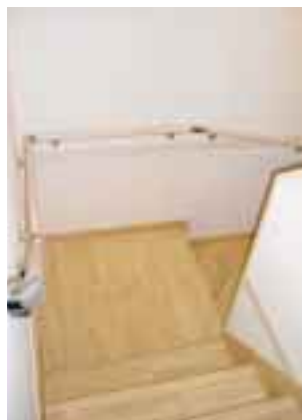
階段は勾配を緩やかに、回り部分もスムーズな動きで昇降でき、転落の危険を考慮して踊り場を設けています。
