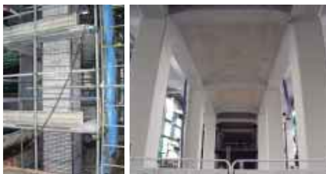
高架橋耐震工事 工事中(左)／完成(右)
