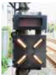
踏切動作反応灯 遮断かんが確実に下りていることを、接近する列車の運転士に知らせます。
