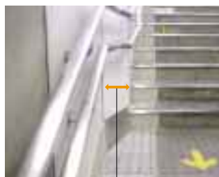
階段幅を狭くしました
