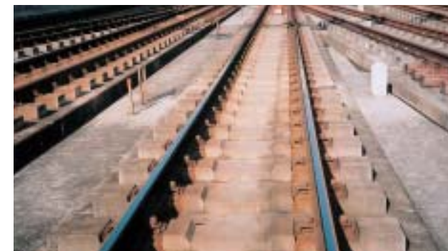
コンクリート道床のようす
