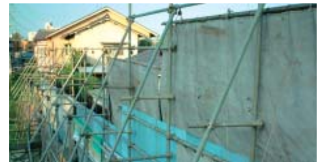
防音シート設置状態
