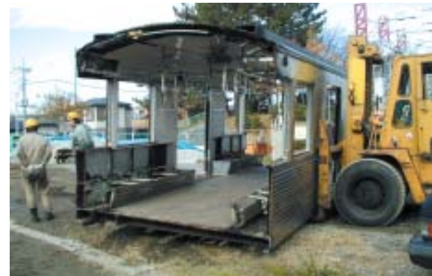
解体作業中のステンレス車両
