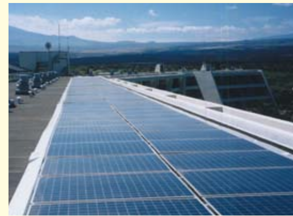
屋上に設置されたソーラーパネル
