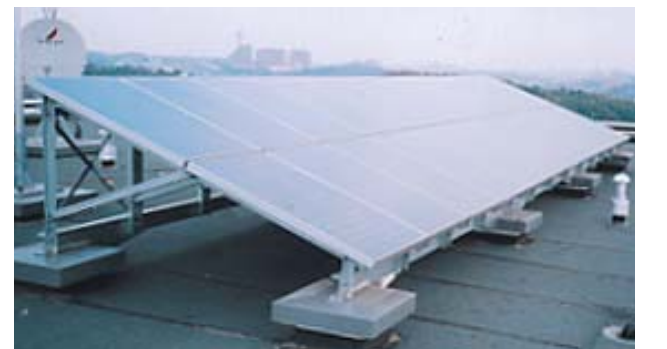
屋上に設置されたソーラーパネル
