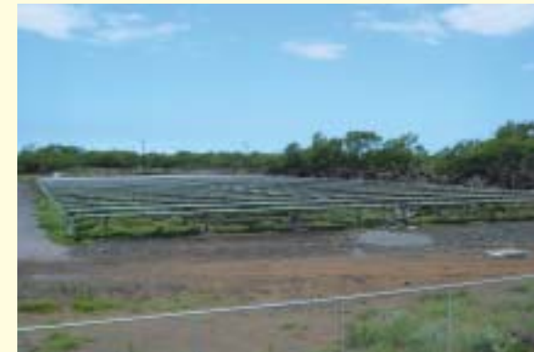
2002年度に新たに設置されたソーラーパネル
