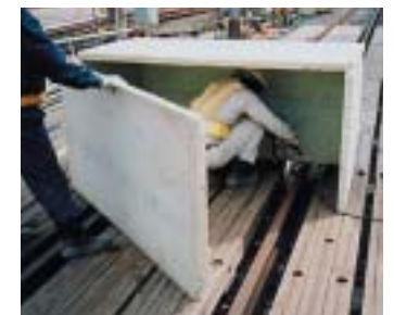
作業による騒音を低減するために、作業者の周囲を防音パネルで覆う工夫をしている様子
