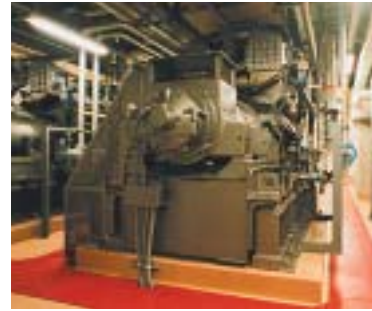
コ・ジェネレーション設備
