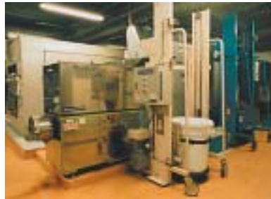
生ごみ処理設備
