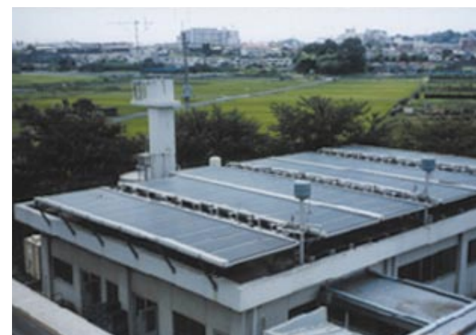
ソーラーシステム 建物の屋上に設置された太陽光集熱パネル
