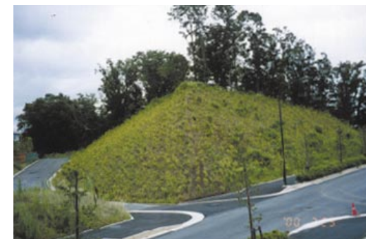
ポット苗工法により、従来の植生復元に取り組んでいる再生緑地(平塚市五領ヶ台特定土地区画整理事業)
