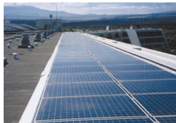
マウナラニ ベイ ホテル&バンガロースの屋上に設置された太陽光パネル
