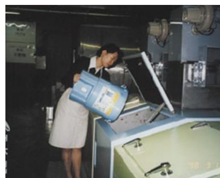
世田谷ビジネススクエア内の生ごみ処理機：東急コミュニティー
