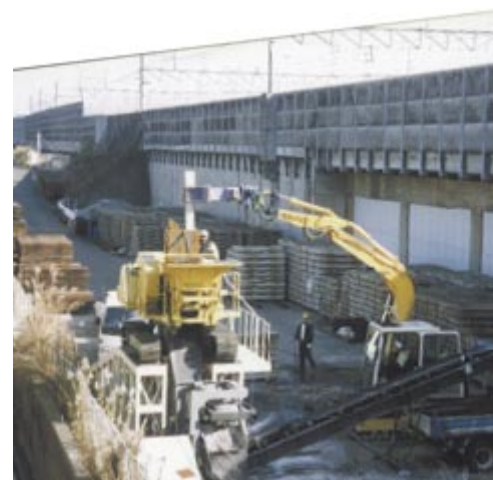
コンクリートがらの再利用 ガラバゴス: コンクリート塊(写真では枕木)を砕く破砕機。
