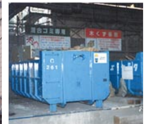
セルリアンタワーの分別廃棄場所 建設工事に伴い発生する廃材を6分 別してリサイクルしています。
